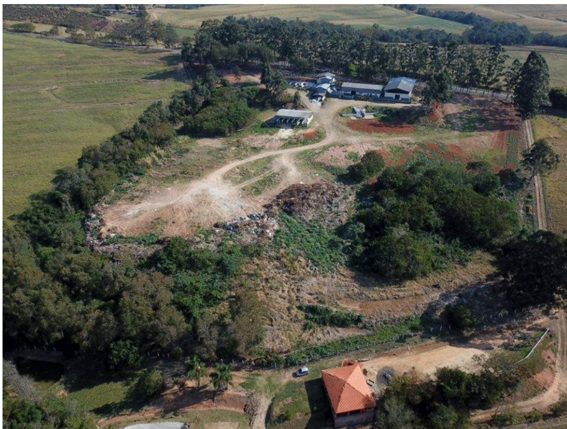
Figura 2 - Antigo Aterro Sanitário do município de Ibatí.
